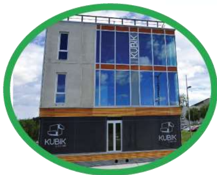
Modernizace budovy TECNALIA "KUBIK" (ES)
